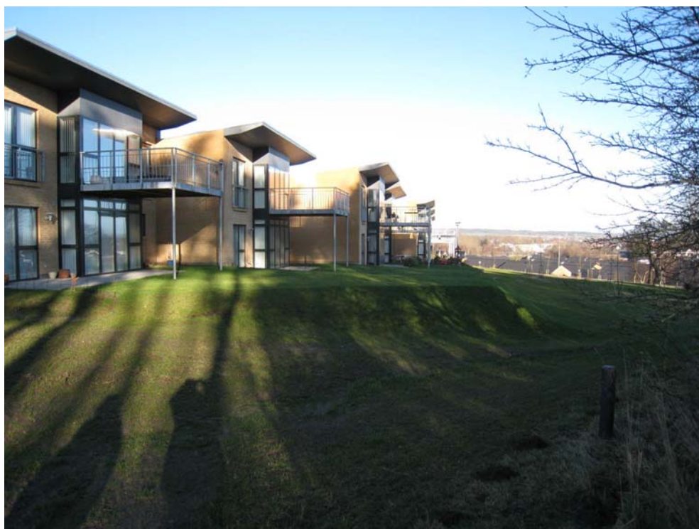
Et eksempel på en 2 etagers rækkehusbebyggelse fra nabobebyggelsen Udsigten
